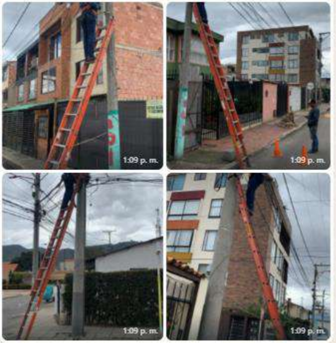
Mantenimiento de camaras junta de comunal ciata
