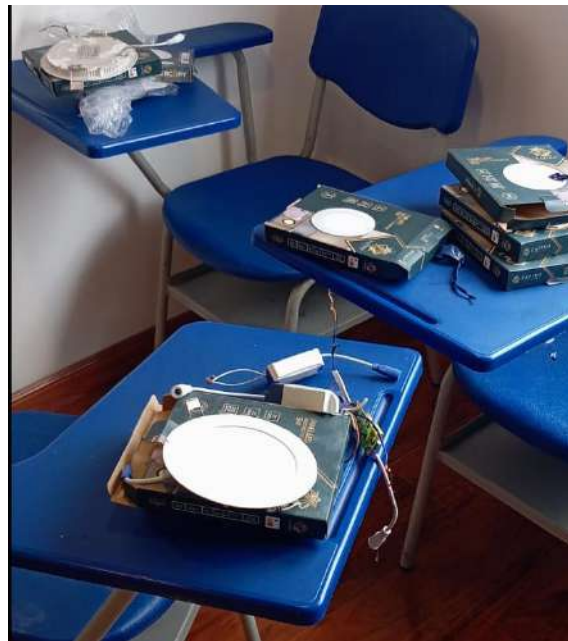
Reemplazo de siete luminarias LED tipo plafón en área interna de los salones y el corredor exterior del patio
