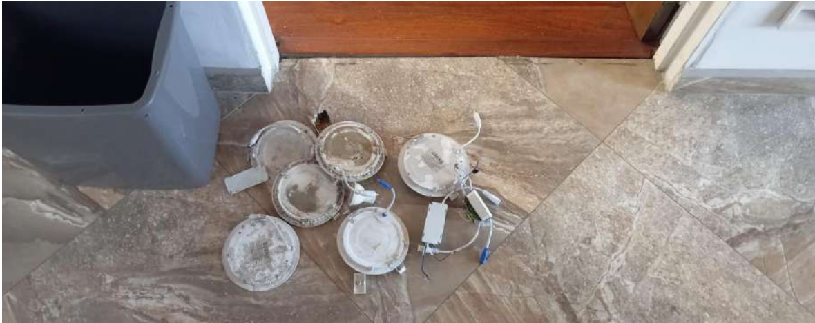
Reemplazo de seis luminarias tipo LED spot que presentaban fallas o fundidas.
