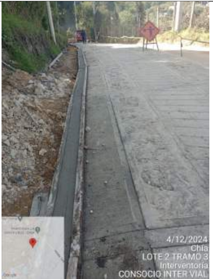
Fundida de bordillo y amarre de acero Tramo 3 – Sector Quebradahonda
