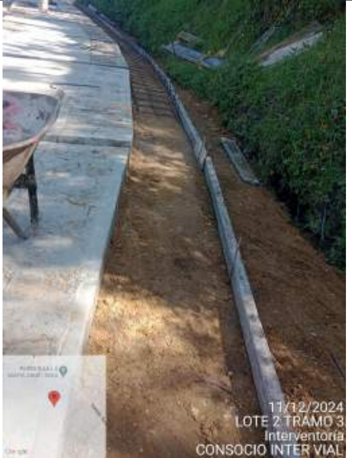
Replanteo de cuneta Tramo 3 – Sector Quebradahonda
