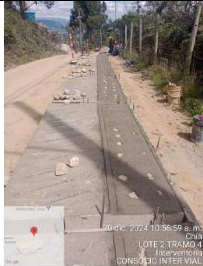
Fundida de concreto ciclópeo de 0.55 x 2.85 x 0.15 m Tramo 4 -Sector Puente San Fermín
