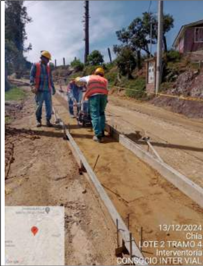
Replanteo de y fundida de huellas Tramo 4 -Sector Puente San Fermín
