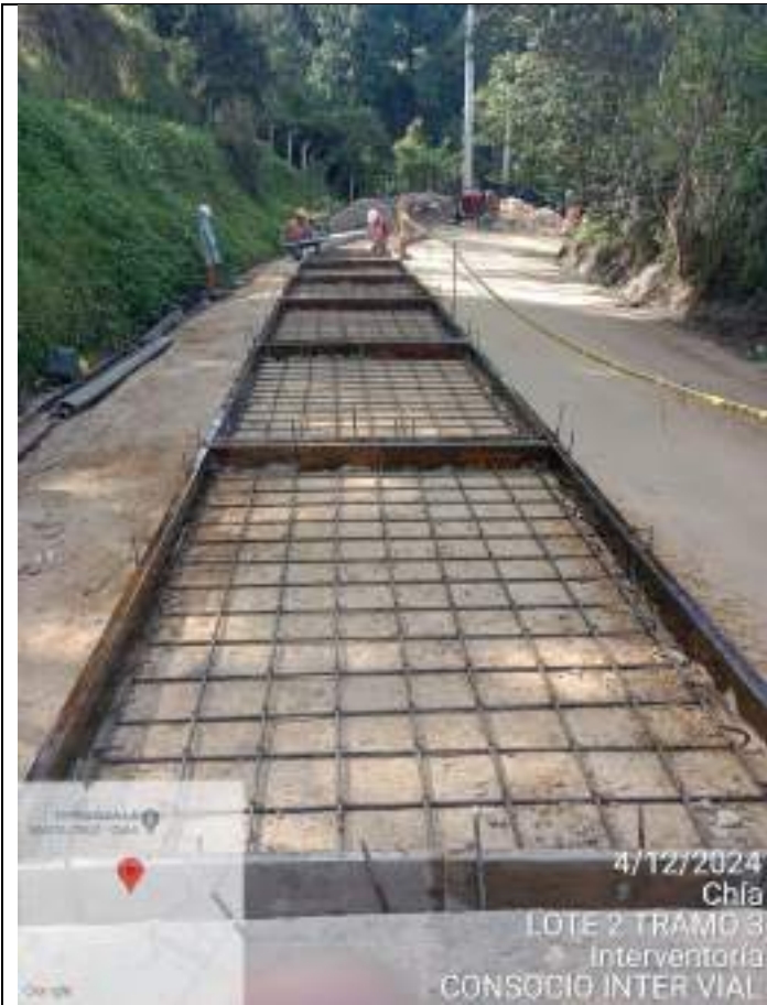
Fundida de bordillo y amarre de acero Tramo 3 – Sector Quebradahonda
