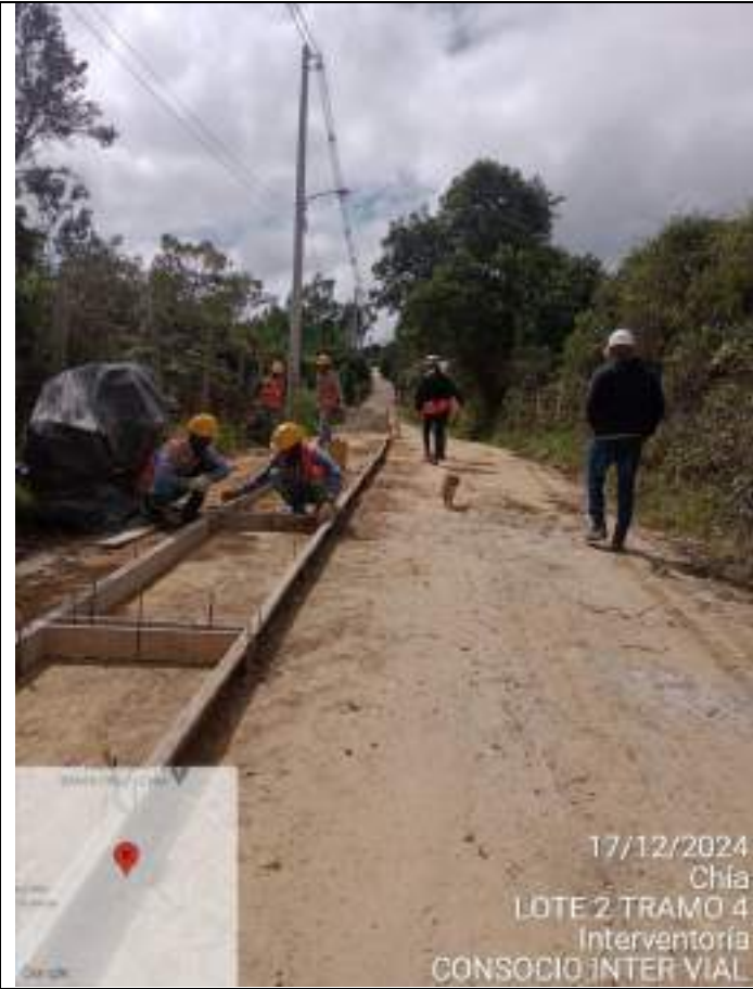
Encofrado y fundida de huellas Tramo 4 -Sector Puente San Fermín
