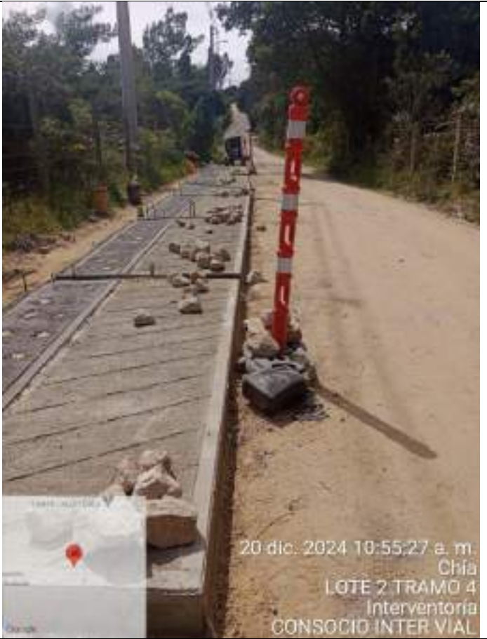
Fundida de concreto ciclópeo de 0.55 x 2.85 x 0.15 m Tramo 4 -Sector Puente San Fermín
