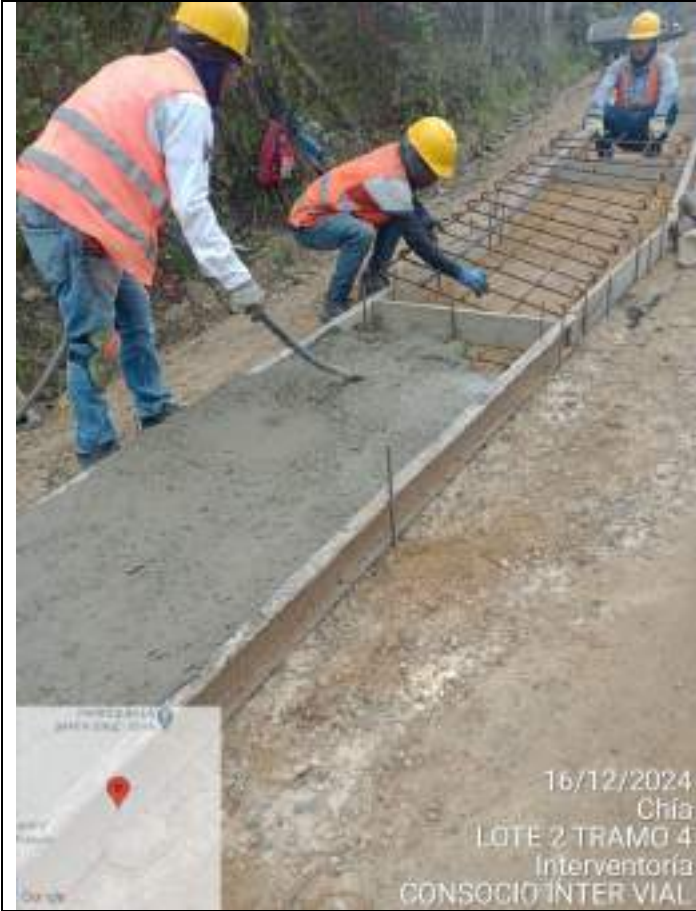
Fundida de huellas Tramo 4 -Sector Puente San Fermín
