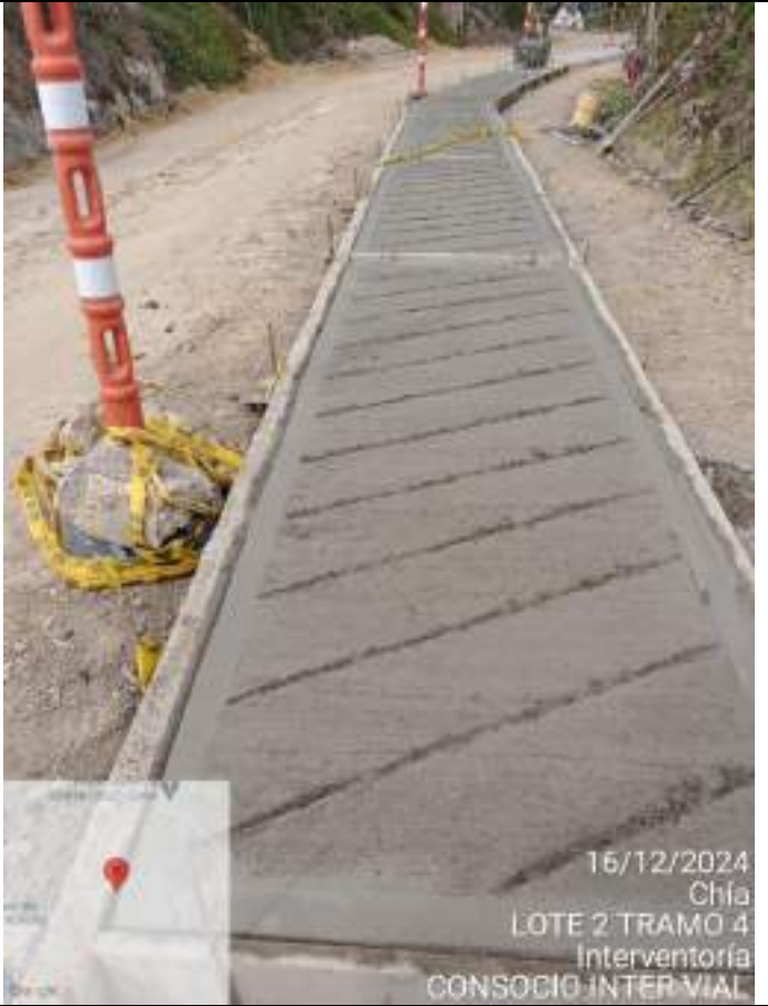
Fundida de huellas Tramo 4 -Sector Puente San Fermín
