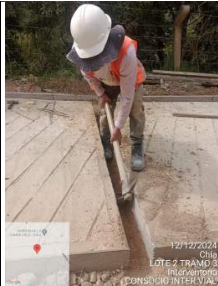
Excavación de vigas, replanteo y acero de refuerzo de cunetas Tramo 3 – Sector Quebradahonda
