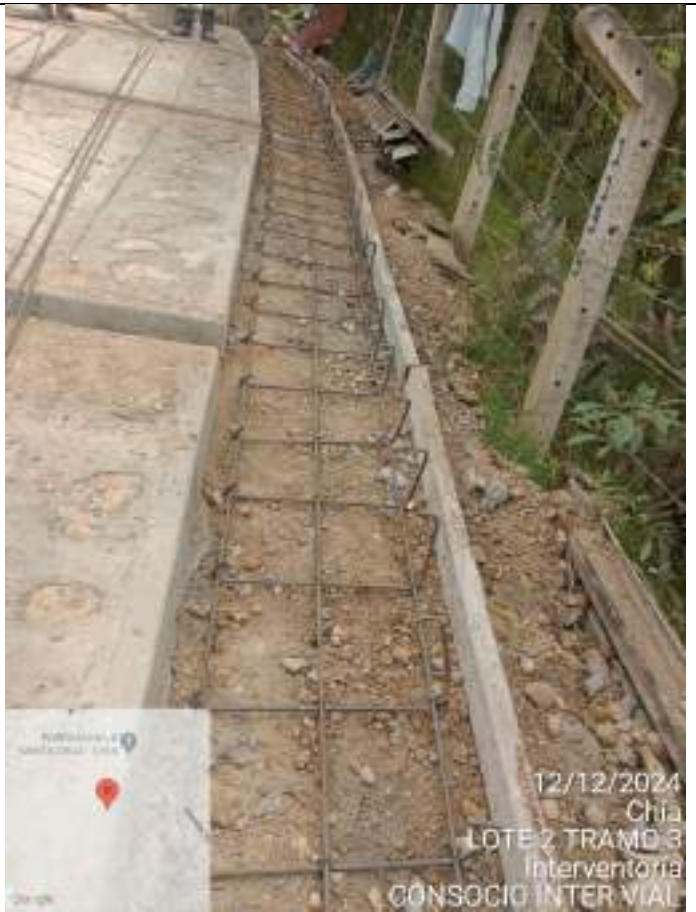
Excavación de vigas, replanteo y acero de refuerzo de cunetas Tramo 3 – Sector Quebradahonda
