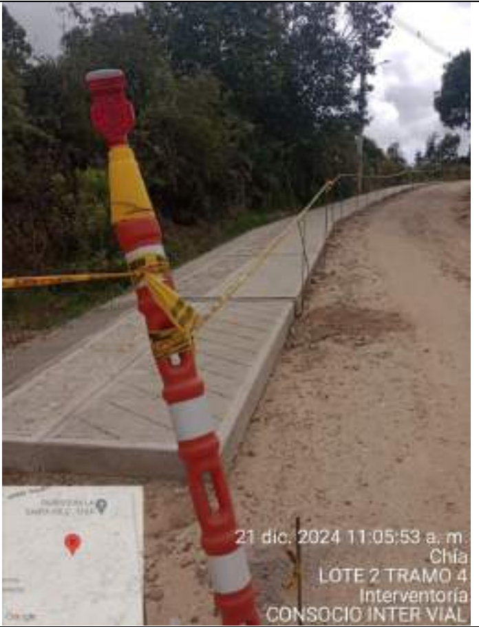
Señalización vial y delimitación de zona de trabajo
