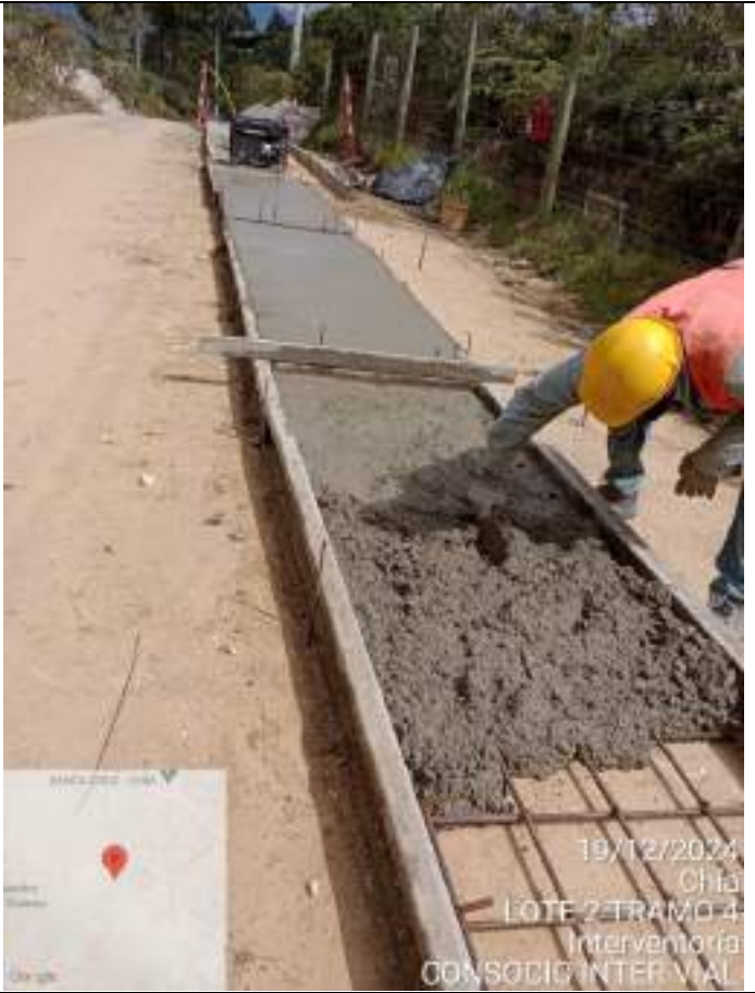
Encofrado y fundida de huellas Tramo 4 -Sector Puente San Fermín
