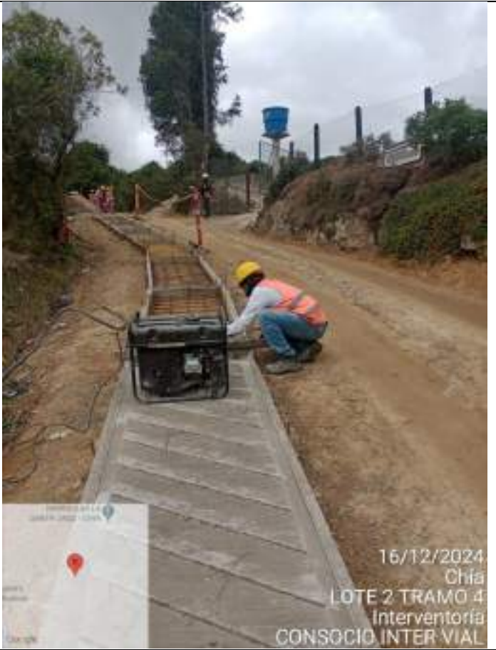
Replanteo de y fundida de huellas Tramo 4 -Sector Puente San Fermín
