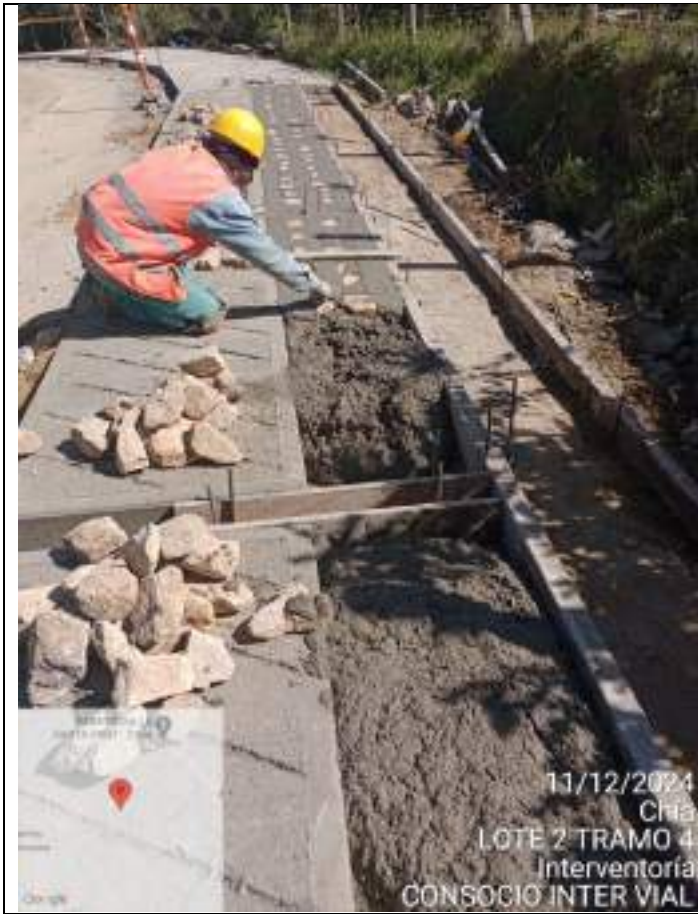
Vaciado de concreto ciclópeo y de huella Tramo 4 -Sector Puente San Fermin
