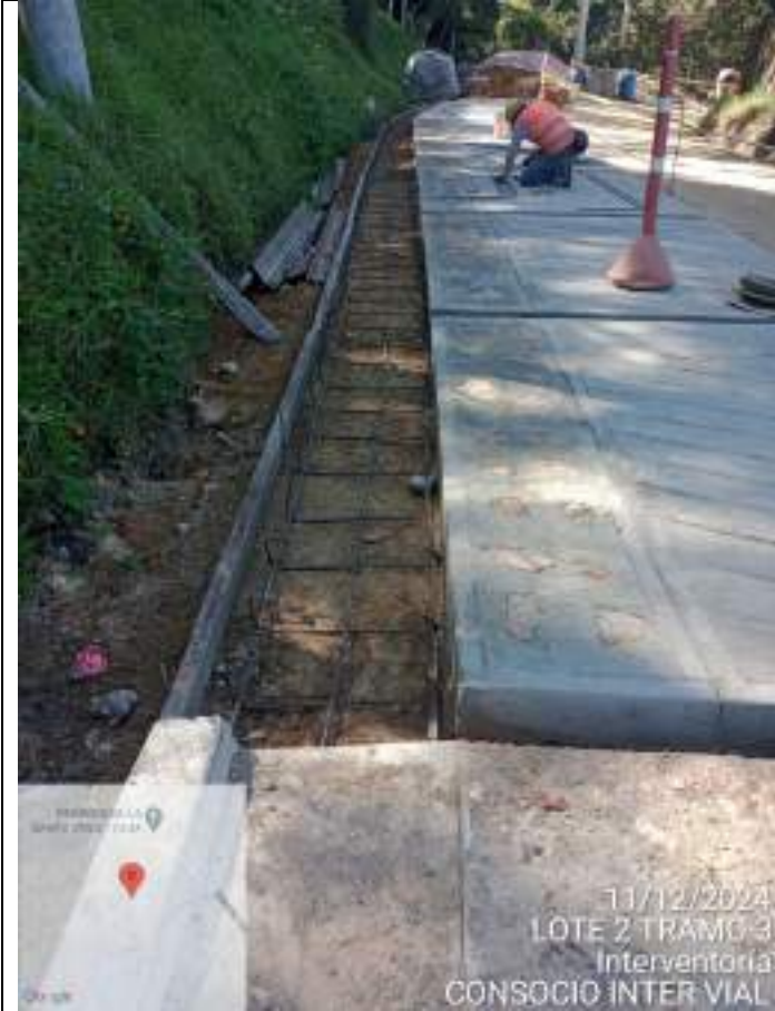
Ciclópeo y acero de cuneta Tramo 3 – Sector Quebradahonda
