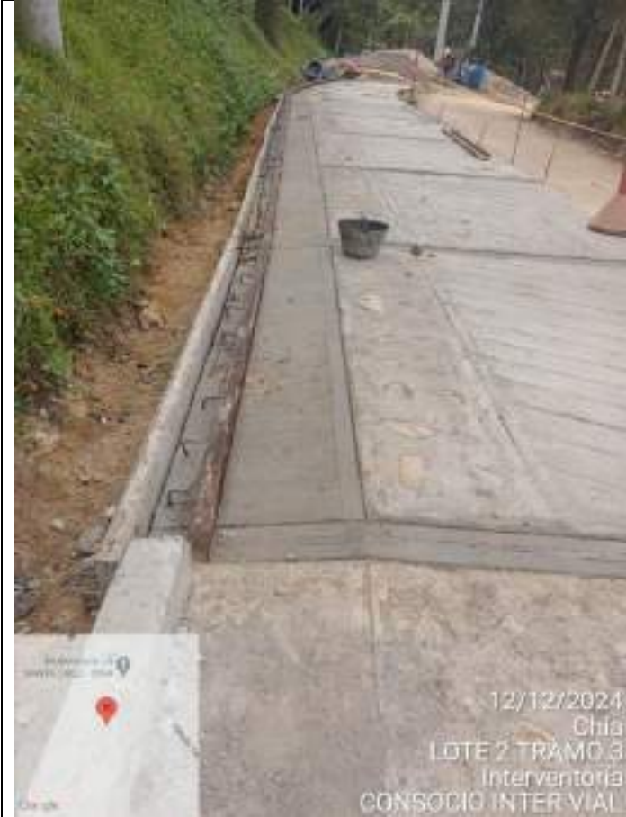
Encofrado de bordillo Tramo 3 – Sector Quebradahonda
