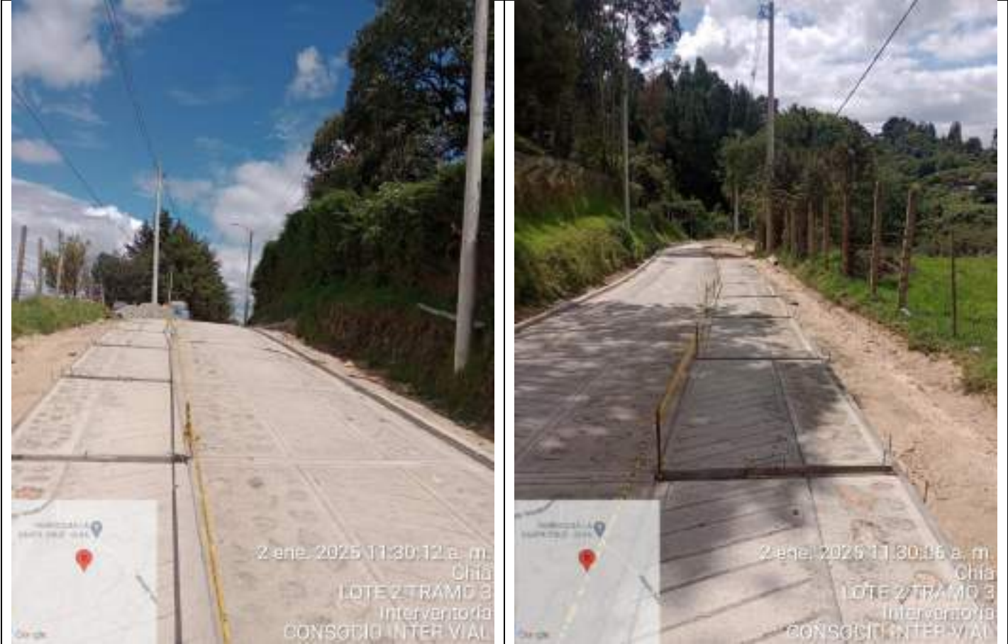
Evidencia de no presencia de trabajadores y señalización Tramo 3 - Sector Quebradahonda
