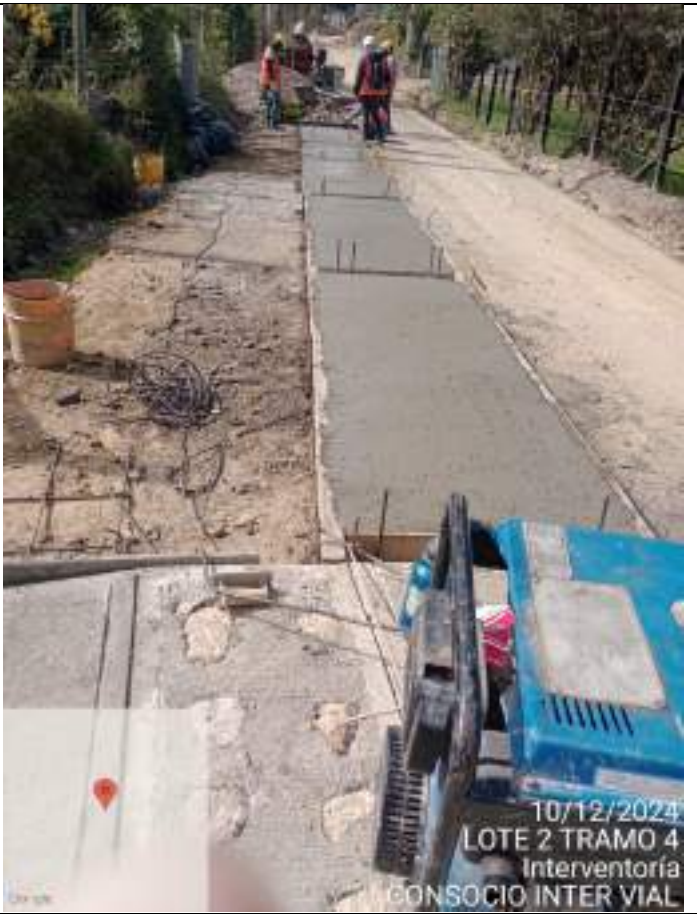
Vaciado de concreto ciclópeo y de huella Tramo 4 -Sector Puente San Fermin
