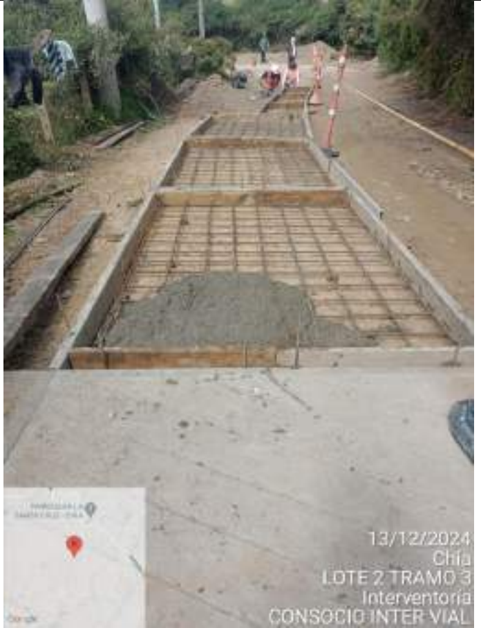
Acero de refuerzo y vaciado de concreto placas de 1.8 x 2.85 x 0.15 m sobre ancho curva Tramo 3 – Sector Quebradahonda
