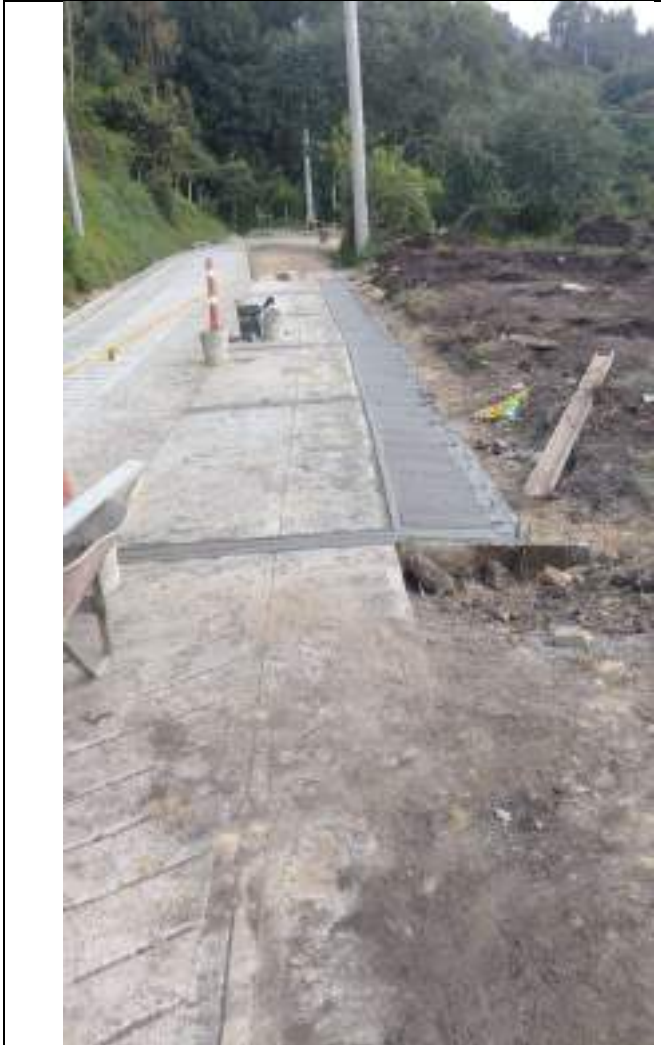
Fundida de cuneta y vigas costado derecho tramo 3 - Sector Quebradahonda Lote 2
