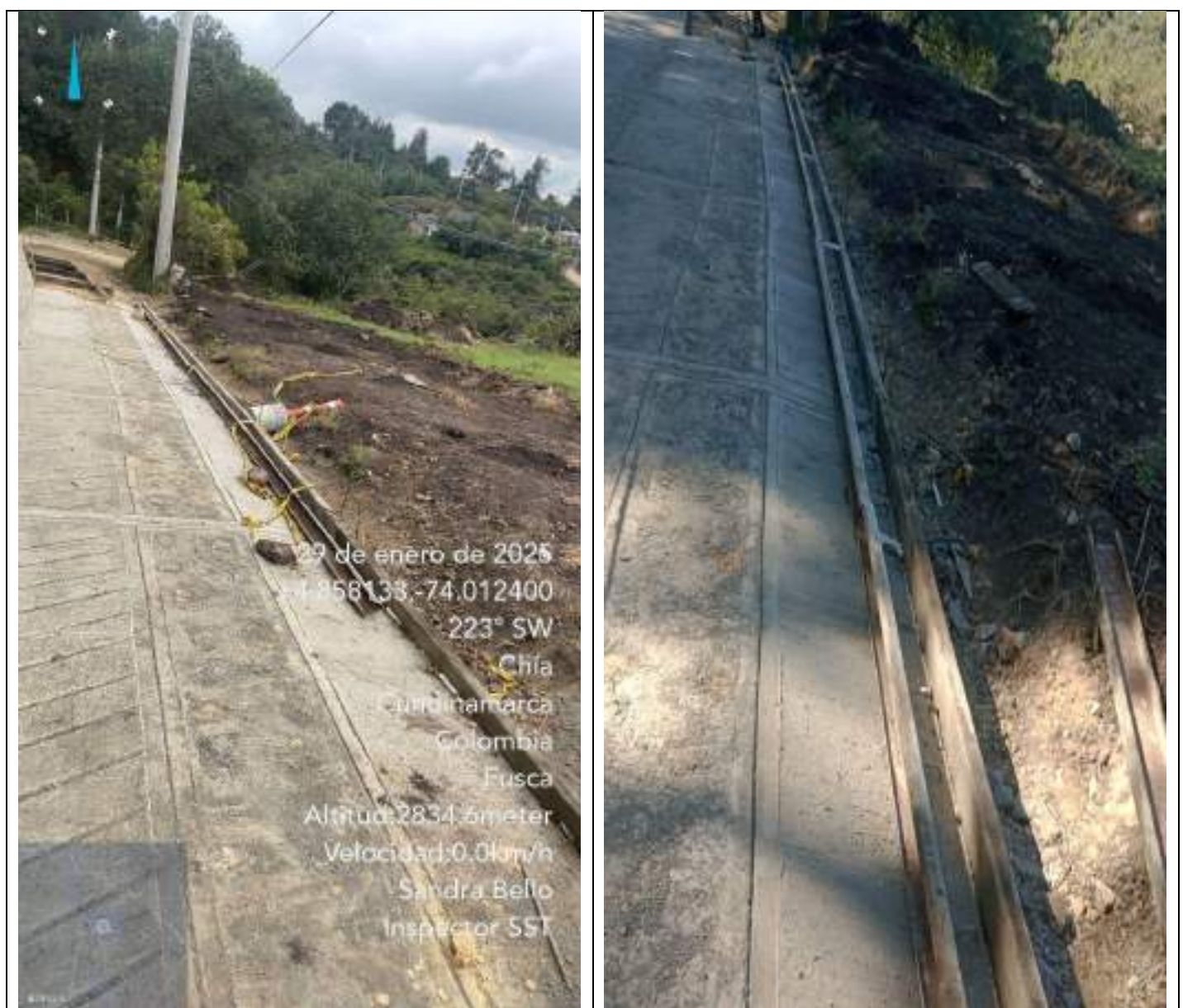
Encofrado para fundida de bordillo sector Quebradahonda – Lote 2
