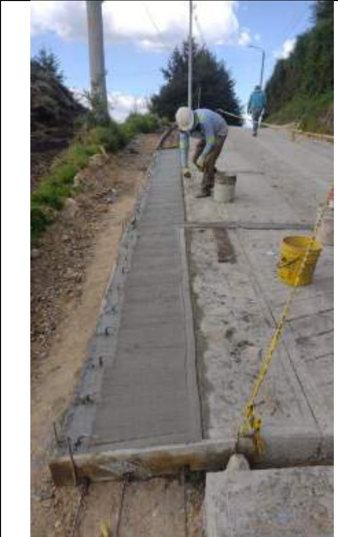
Fundida de cuneta y vigas costado derecho tramo 3 - Sector Quebradahonda Lote 2
