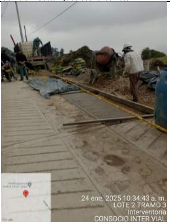
Fundida de huellas costado derecho tramo 3 – Sector Quebradahonda Lote 2
