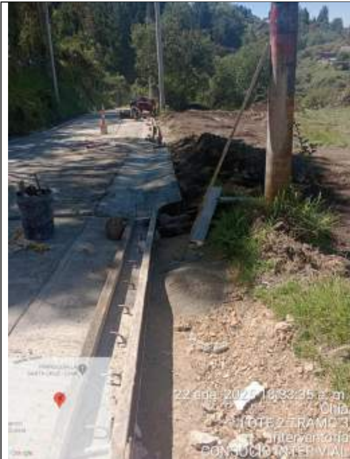
Fundida de cuneta y vigas costado derecho tramo 3 – Sector Quebradahonda Lote 2
