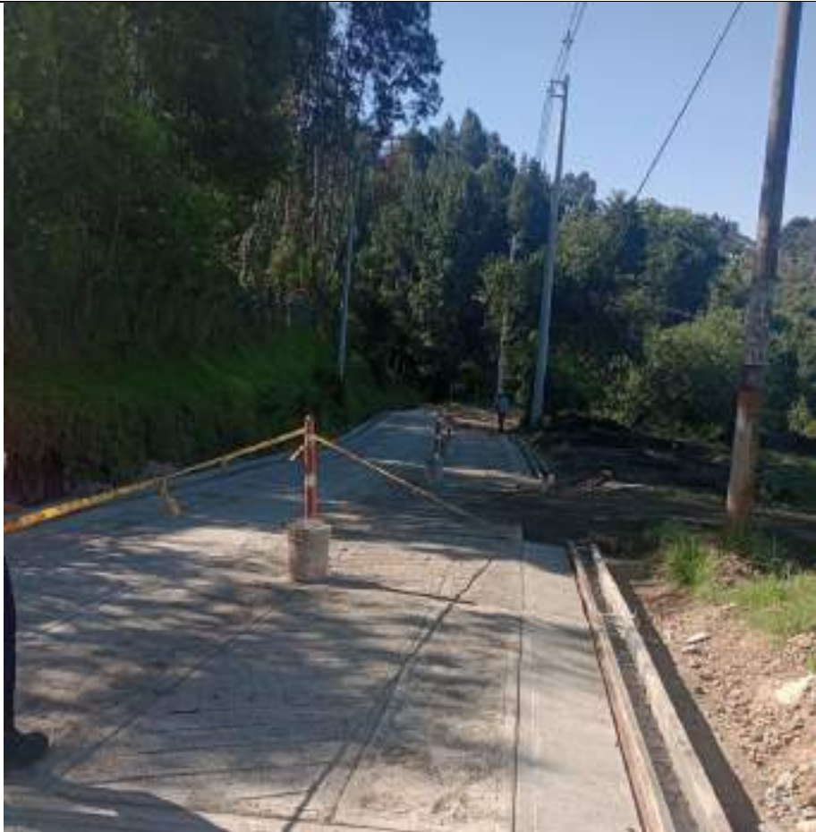
Encofrado para fundida de bordillo sector Quebradahonda – Lote 2
