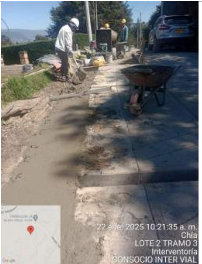
Fundida de cuneta y vigas costado derecho tramo 3 – Sector Quebradahonda Lote 2
