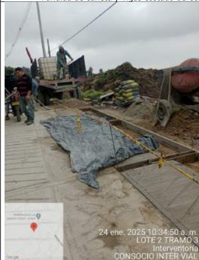
Fundida de huellas costado derecho tramo 3 – Sector Quebradahonda Lote 2
