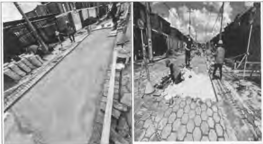
Figura 15: Instalación adoquín de arcilla parque rio frío.
