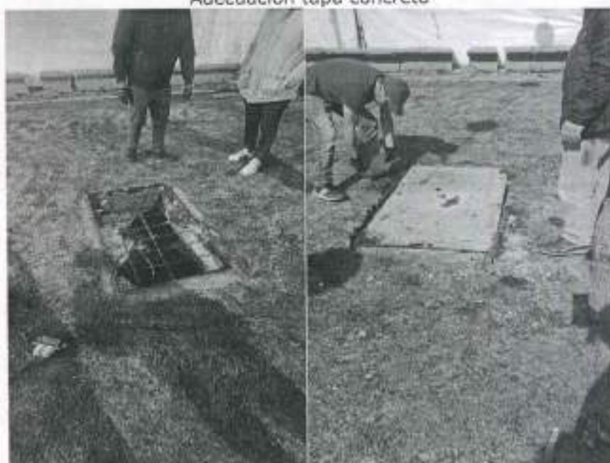
Adecuación tapa concreto
