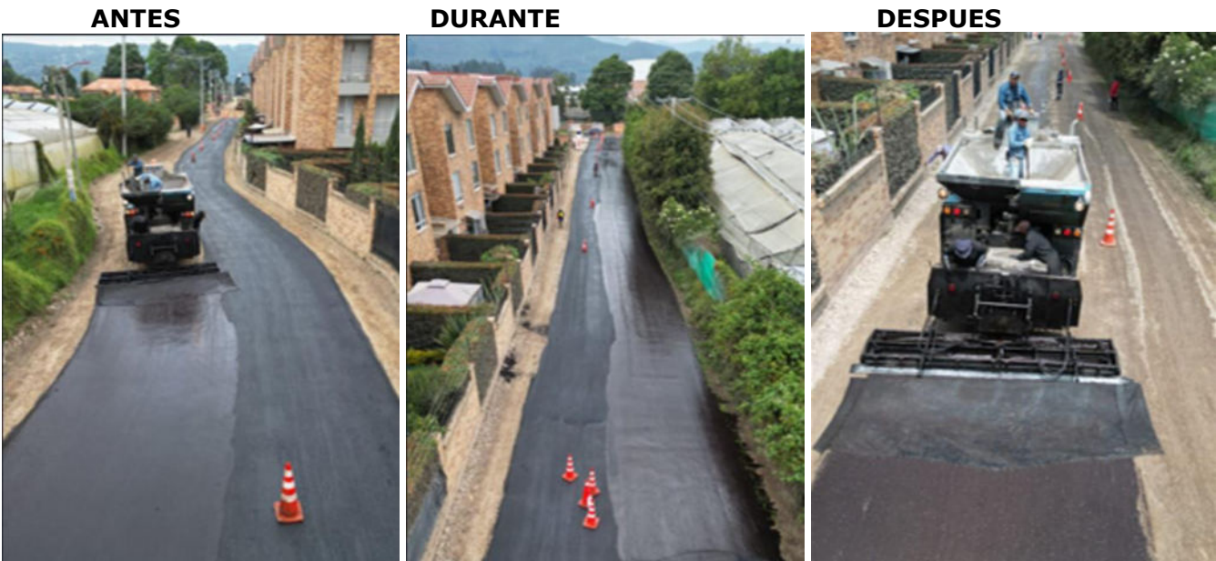
1.19 Calle 23 entre carreras 9 y 5
