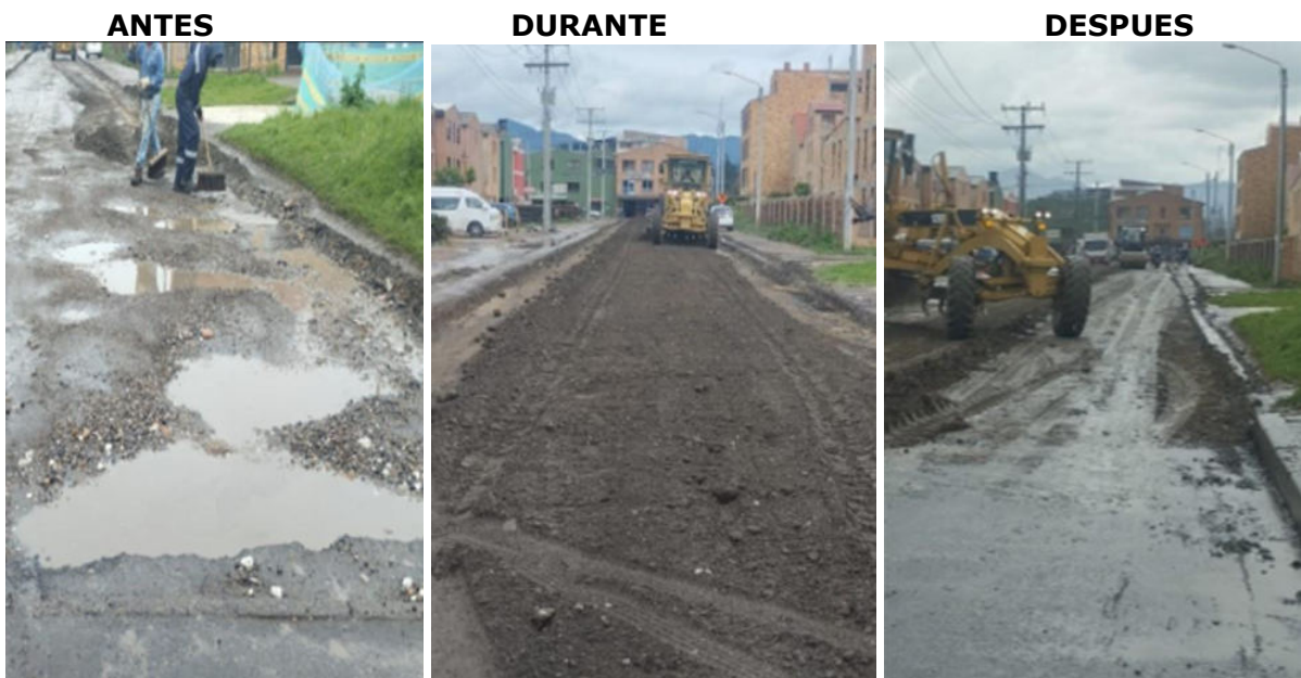
1.13 Calle 31 entre carreras 4 y 3
