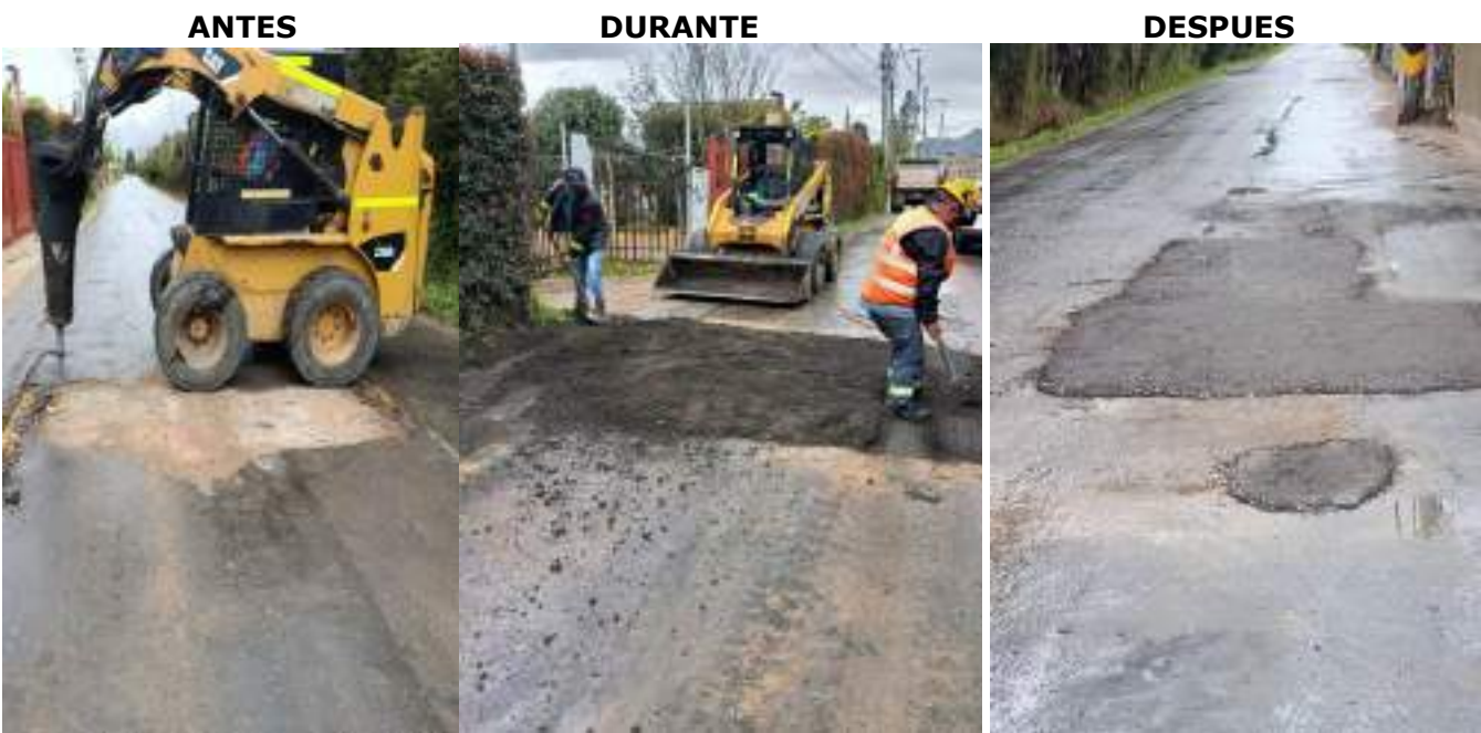
1.18 Camino El cerro entre Camino La Leonor y Vía a Tabio
