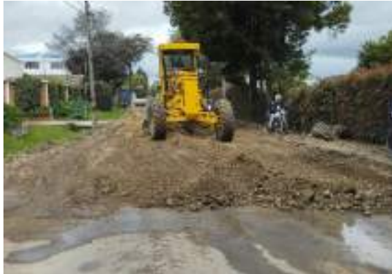
- Carrera 11 entre calle 29 y camino Guanata (Conformación de calzada)
