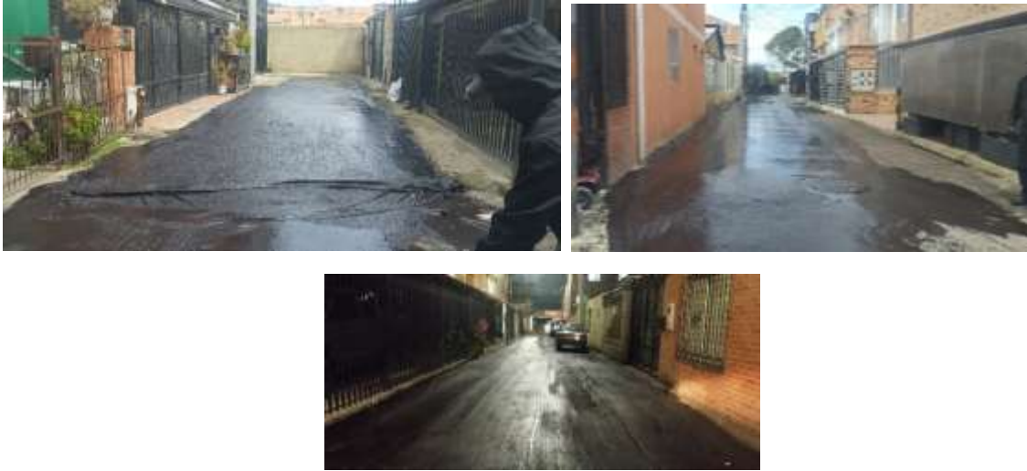
- Aplicación de sello slurry el Cairo sector codensa
