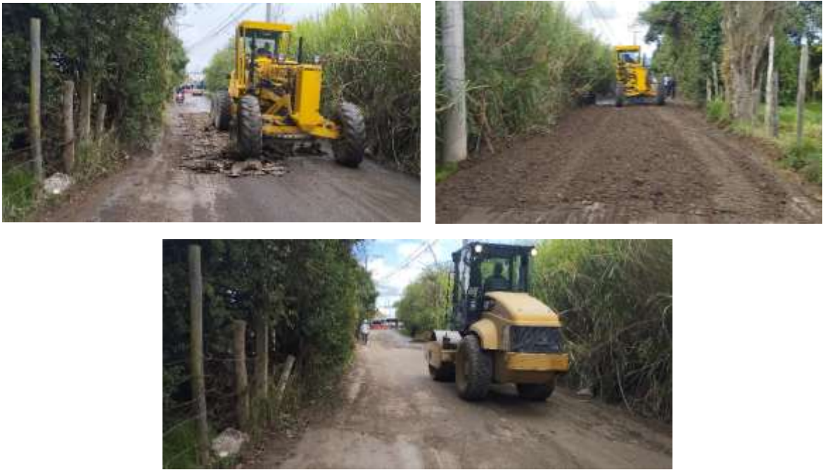
- Conformación de calzada vía sector el chamizo
