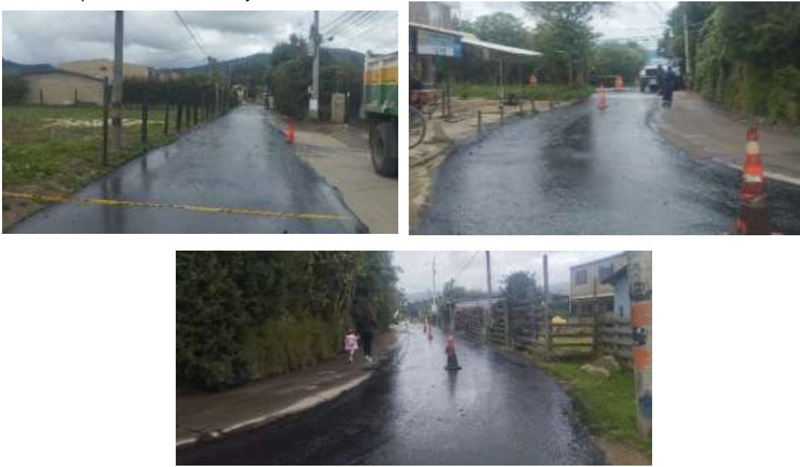
- Aplicación de sello slurry vía Camino Peralta
